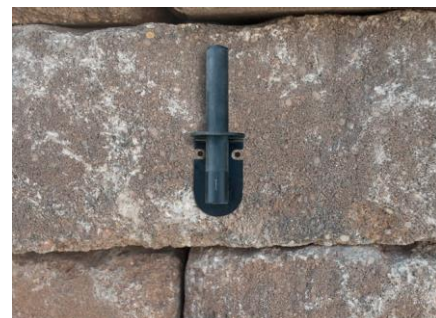
Figure 6.8 - Ajustement à sec du support
