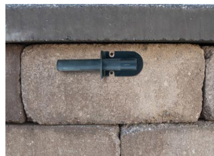
Figure 6.4 - Ajustement à sec du support
